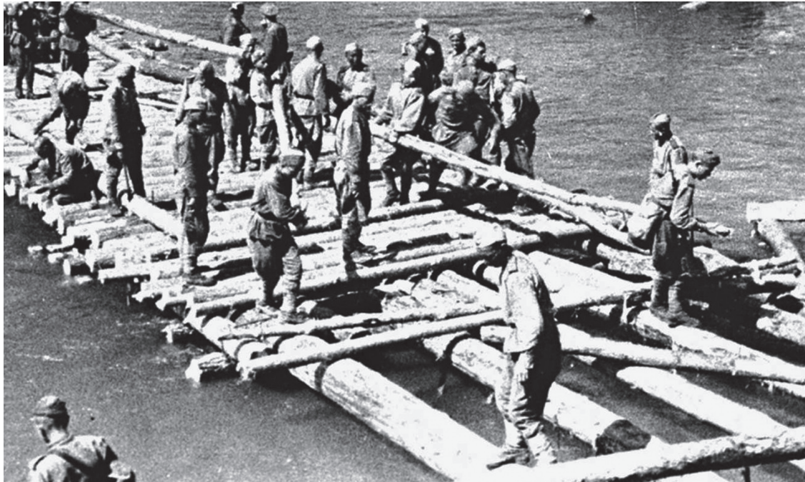
Строительство моста на фронте.
