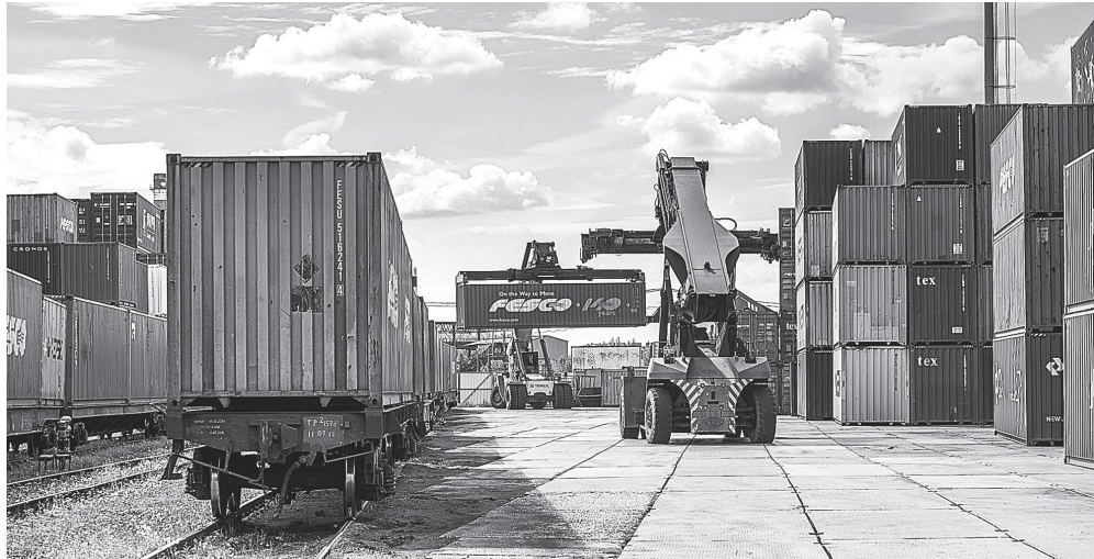
«Леспром ДВ» реализует проект по строительству контейнерного терминала.
